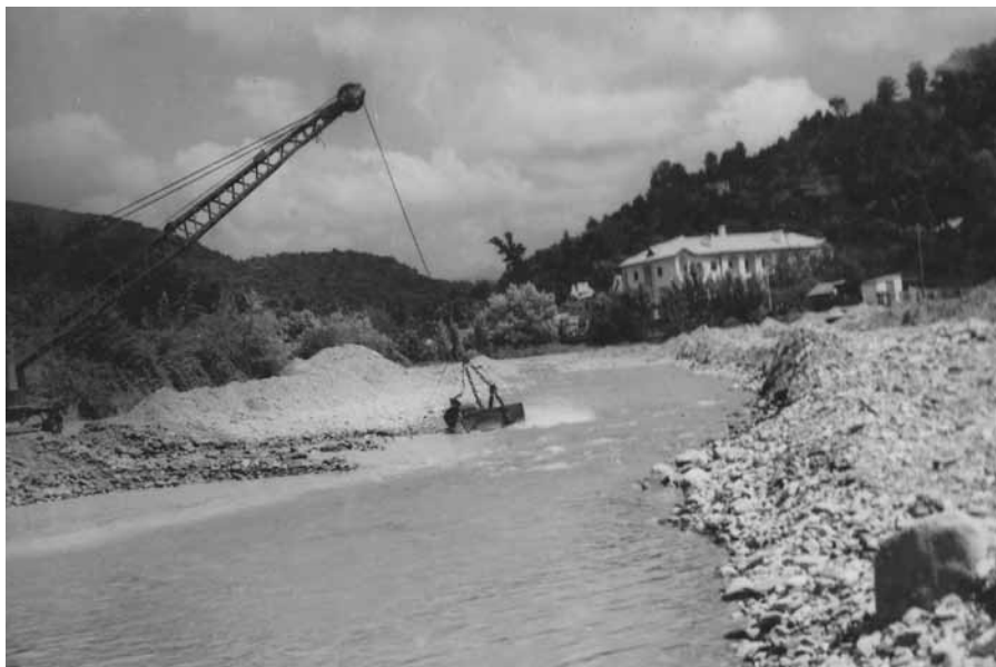
116. Начало взятия реки Хоста в бетонные берега. 1955 г.
