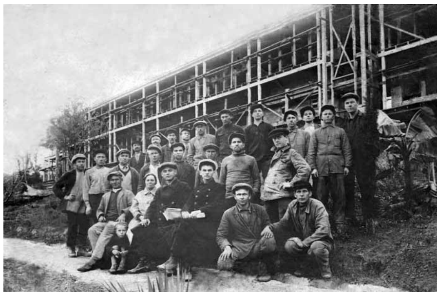
50. Строительство санатория «Красный стрелок». 1933 г. Позднее НКПС «Стрела», «Кавказ 2».
