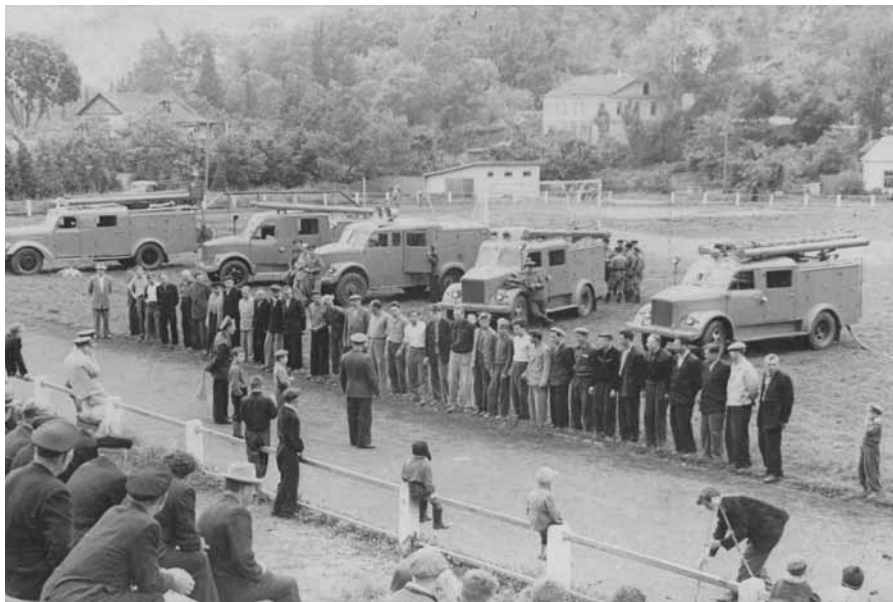
134. Пожарные соревнования на стадионе. 1960 г.
