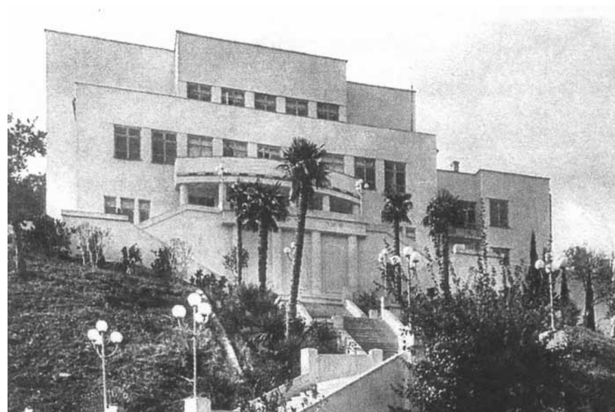
53. Клуб-столовая санатория «Мосэнерго». 1935 г.
