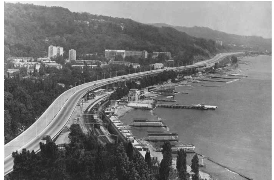
182. Новая эстакада над Хостой. Вид от санатория «Мыс Видный». 1983 г.
