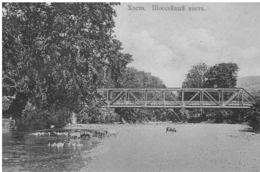
17. Старый шоссейный мост, построен в 1902 г. Открытка 1914 г.
