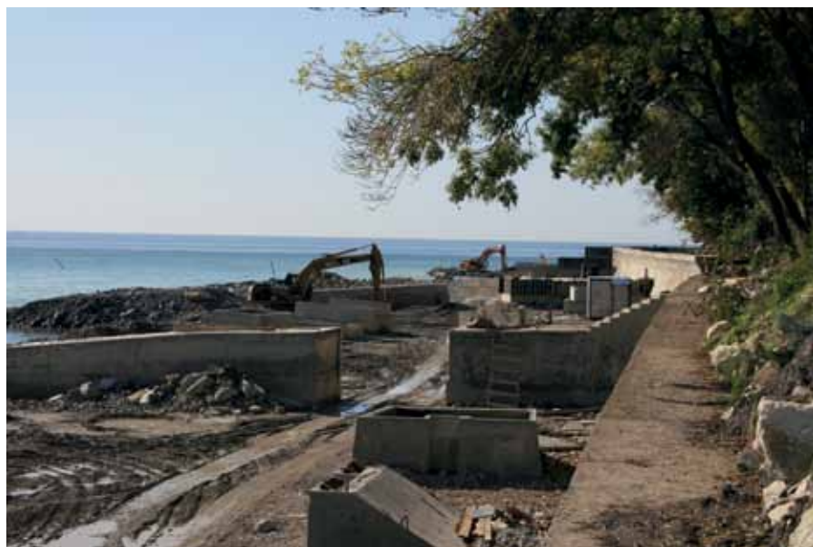
194. Отсыпка нового пляжа на мысе Видном. 2010 г.
